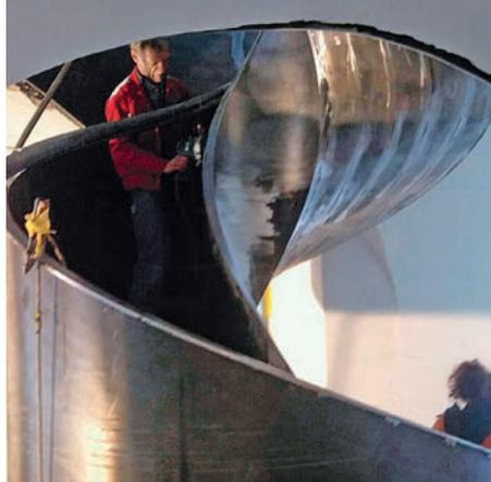
Die Untersicht wird aus fünf Stück «schraubenförmig» gewalzten Blechstreifen zusammengebaut und verschweisst. Der Einbau erfordert einen hohen Grad an handwerklichem Wissen und Können.
