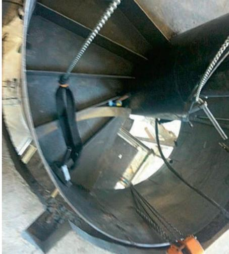
Von oben nach unten laufend erfolgt der Einbau der einzelnen Tritte gleichzeitig mit der äusseren Treppenwange.
