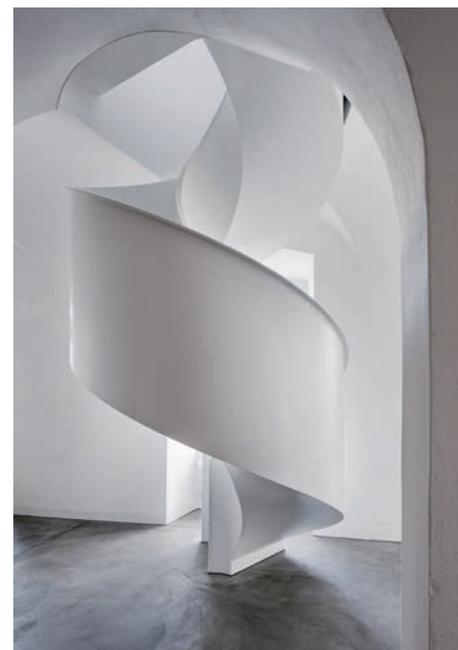
Die Aussenwange ist aus gewalztem, 12 mm starkem Stahlblech gefertigt. Für die Innenwange kam 30 mm-Stahlblech zur Anwendung.
