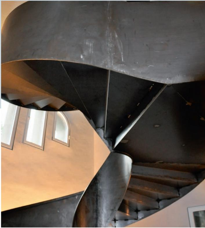
Die neue, komplett aus Stahl gefertigte Innentreppe erschliesst zwei Geschosse und weist eine Gesamthöhe von rund 8 m auf.
