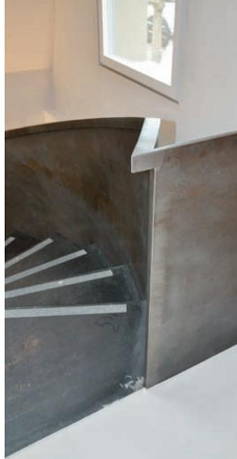
Der Austritt im Obergeschoss: Der Handlauf besteht aus einem Flachstahl 50 x 10 mm.
