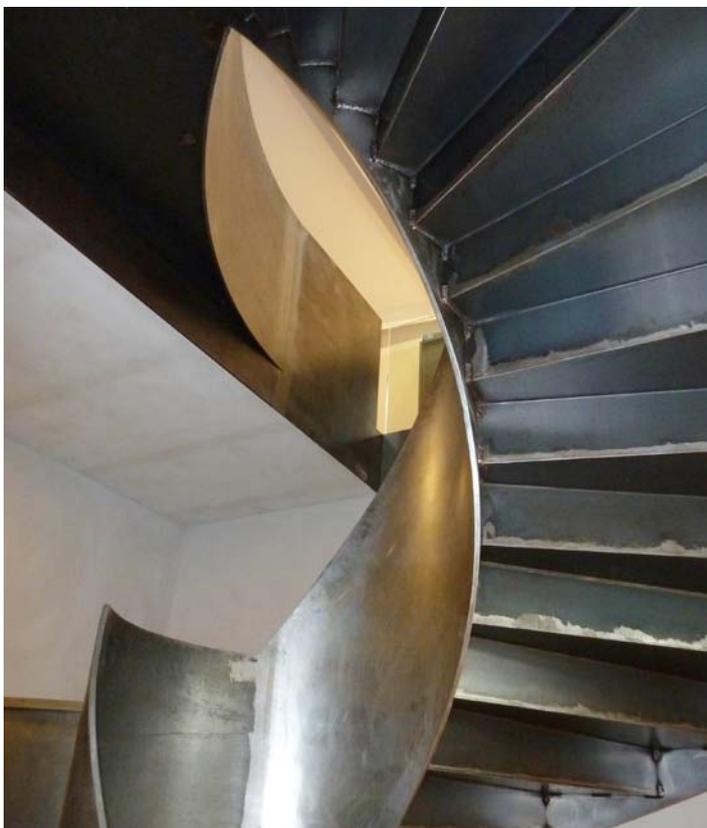
Der innere Wendel aus Stahlblech 15 mm weist naturgemäss eine hohe Eigensteifigkeit aus. Hier wurde bei der schweisstechnischen Fertigung besonders darauf geachtet, die Eigenspannungen möglichst tief zu halten und diese über den gesamten Querschnitt gleichmässig zu verteilen.
