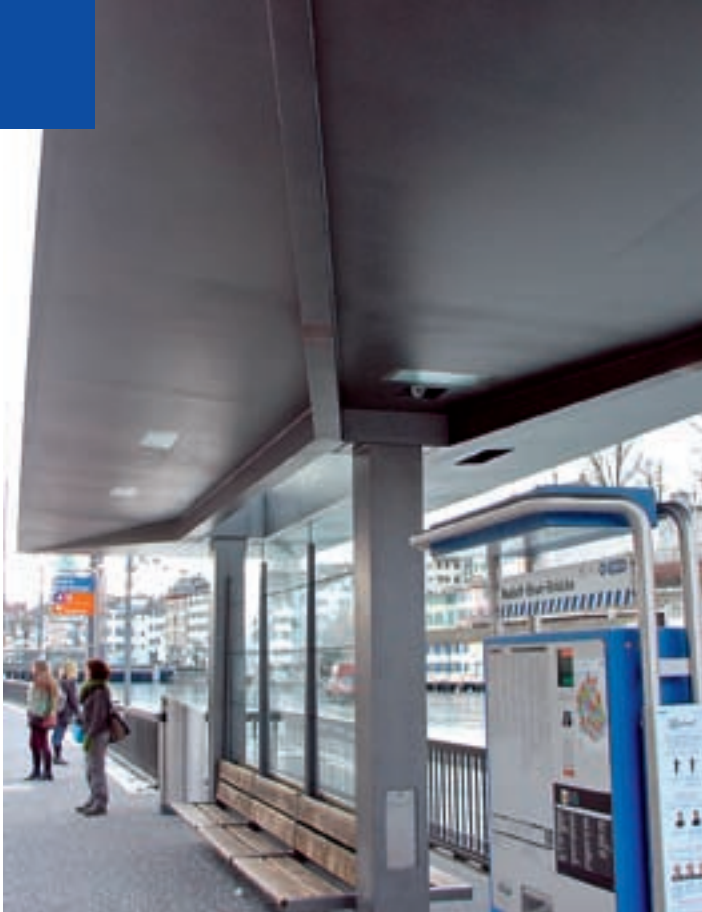
Links: Dachuntersicht mit gut zu erkennenden, konisch verlaufenden Kastenträgern Rechts: Hinter den Geländern, direkt über dem Wasser schwebt der Balkon.
