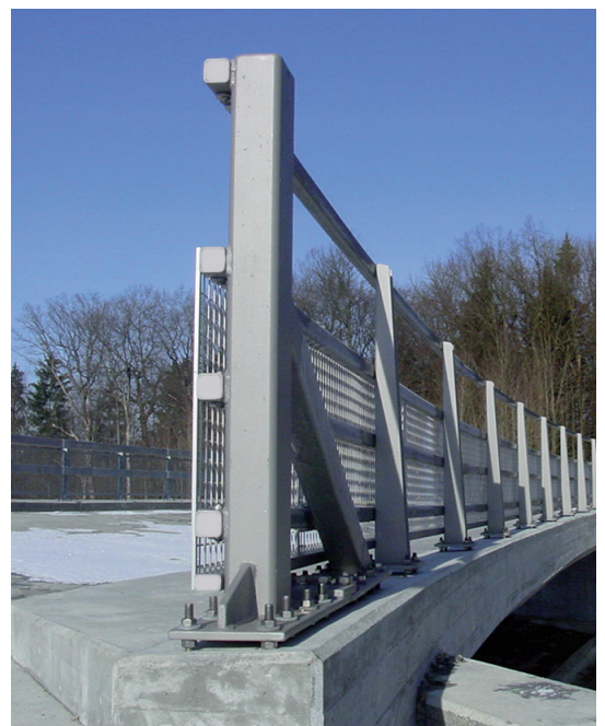
Mit Übersteigschutz und Abspannvariante.
