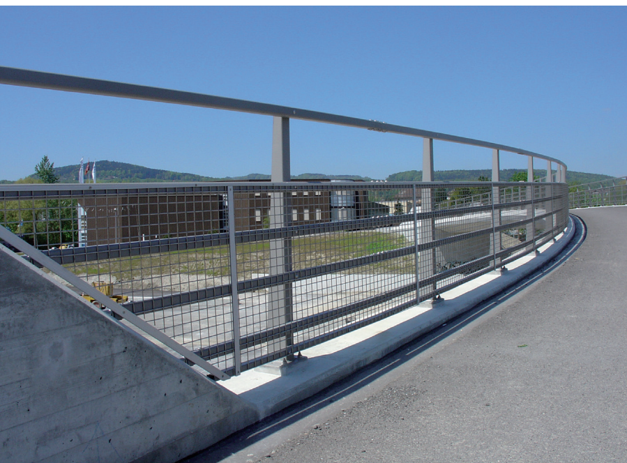
Erhöht für Fahrradverkehr, mit Übersteigschutz und Abspannvariante.
