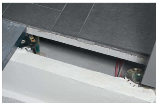
Faux-plancher fixe dans salle d'eau, doté d'un revêtement céramique
