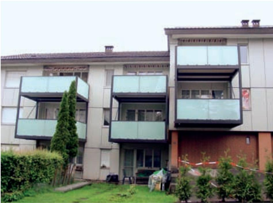
**Balkonkonstruktion an der Fassade angehängt**
