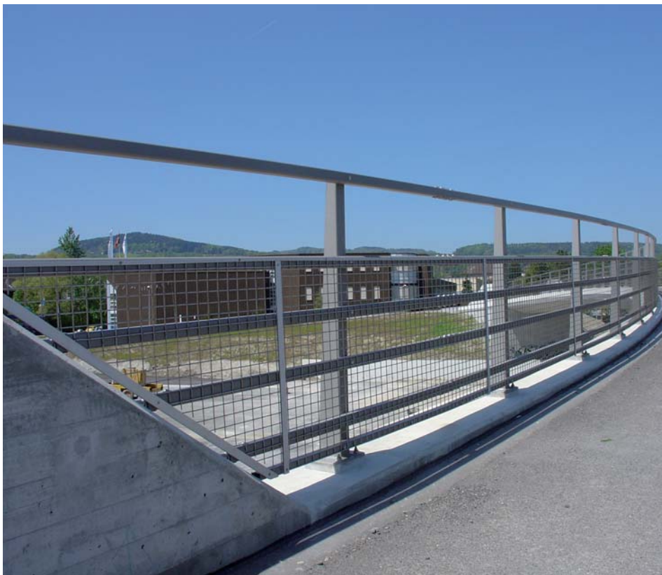
Erhöht für Fahrradverkehr, mit Übersteigschutz und Abspannvariante.
