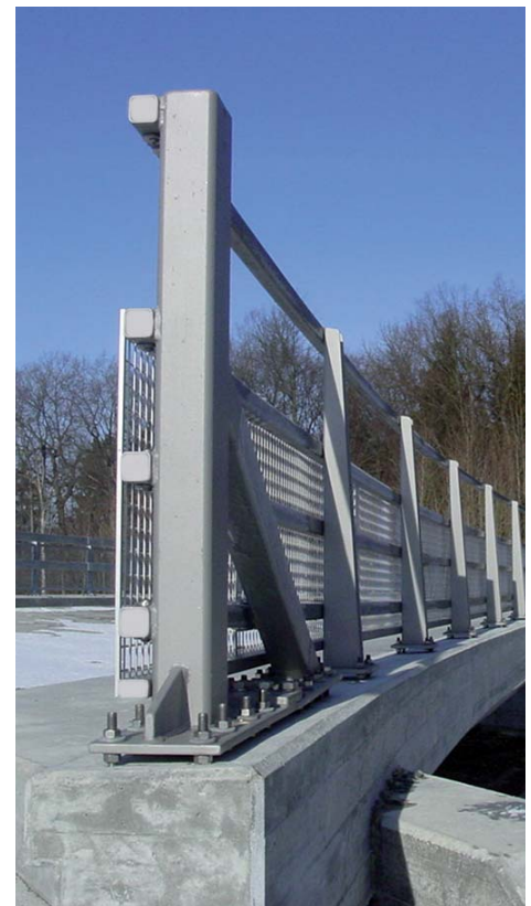
Mit Übersteigschutz und Abspannvariante.
